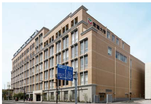
常葉大学静岡キャンパス水落校舎の外観
